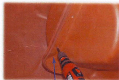
Raccordement du local Dolium Boulonnage + silicone
